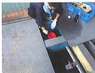
WS-01820污水排放口
